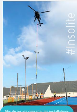
Afin de ne pas dégrader les installations mises en place et de ne pas freiner l'avancée du chantier, la technique de l'héliportage a été utilisée pour livrer les mâts dans les différentes zones.
