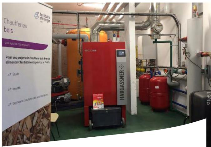
*La chaufferie bois-énergie se substitue aux chaudières à énergie fossile et assure, au moyen d'une énergie locale et renouvelable, la fourniture de chaleur pour ces bâtiments.*
